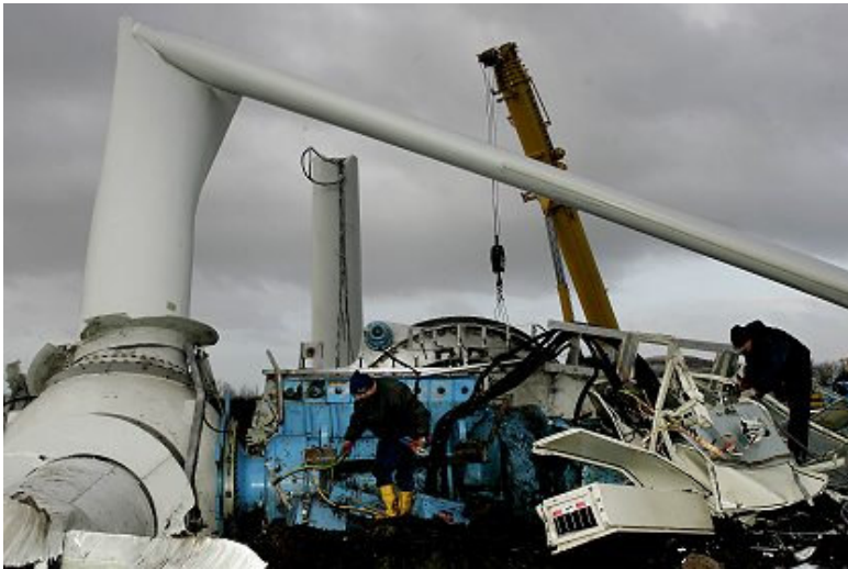
Rys. 7. Części połamanego wiatraka, które upadły blisko autostrady 35
